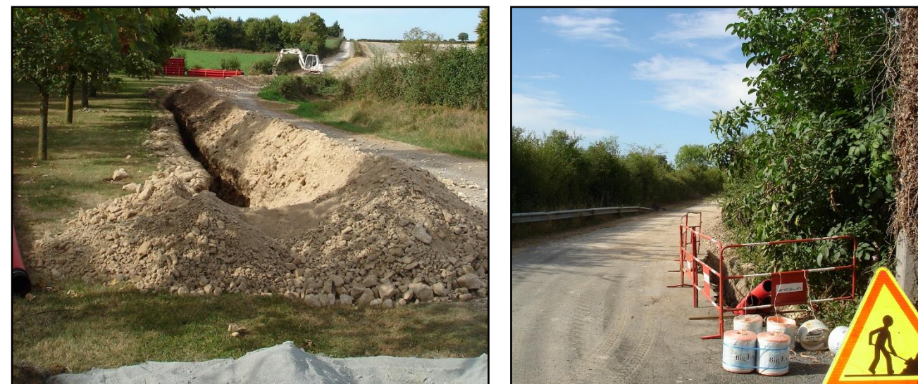
Photo 4 : Exemple de travaux pour le raccordement au réseau public de distribution (Source : VALOREM)
