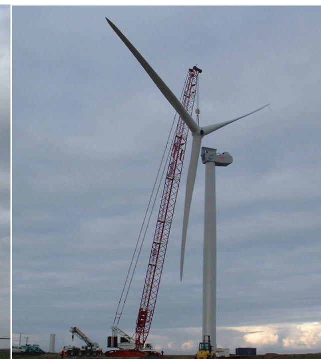
Montage du rotor
